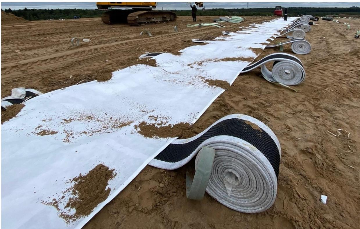
*Рисунок 10 – Монтаж сети дренирующих горизонтальных матов*
