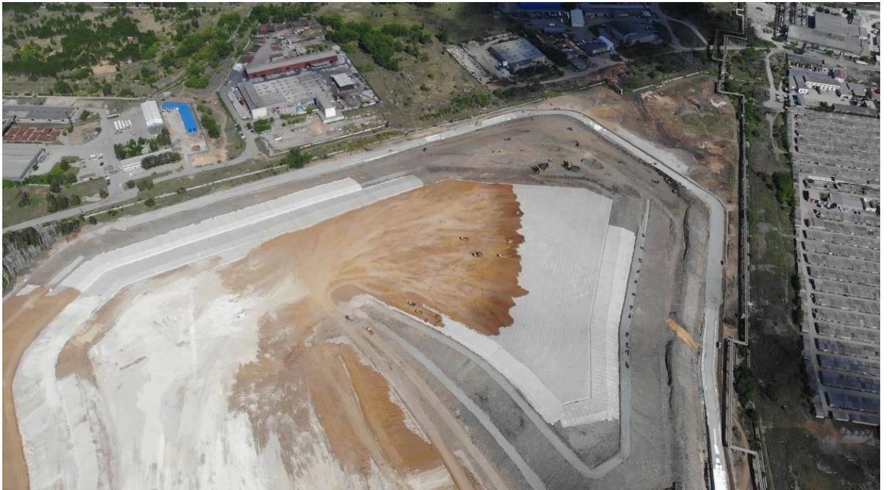
*Рисунок 3 – Отсыпка укрытой поверхности полигона слоем песчаной почвы*
