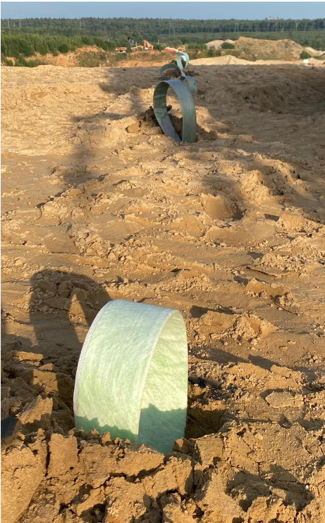
*Рисунок 8 – Концевой участок вертикальной ленточной дрены после монтажа*
