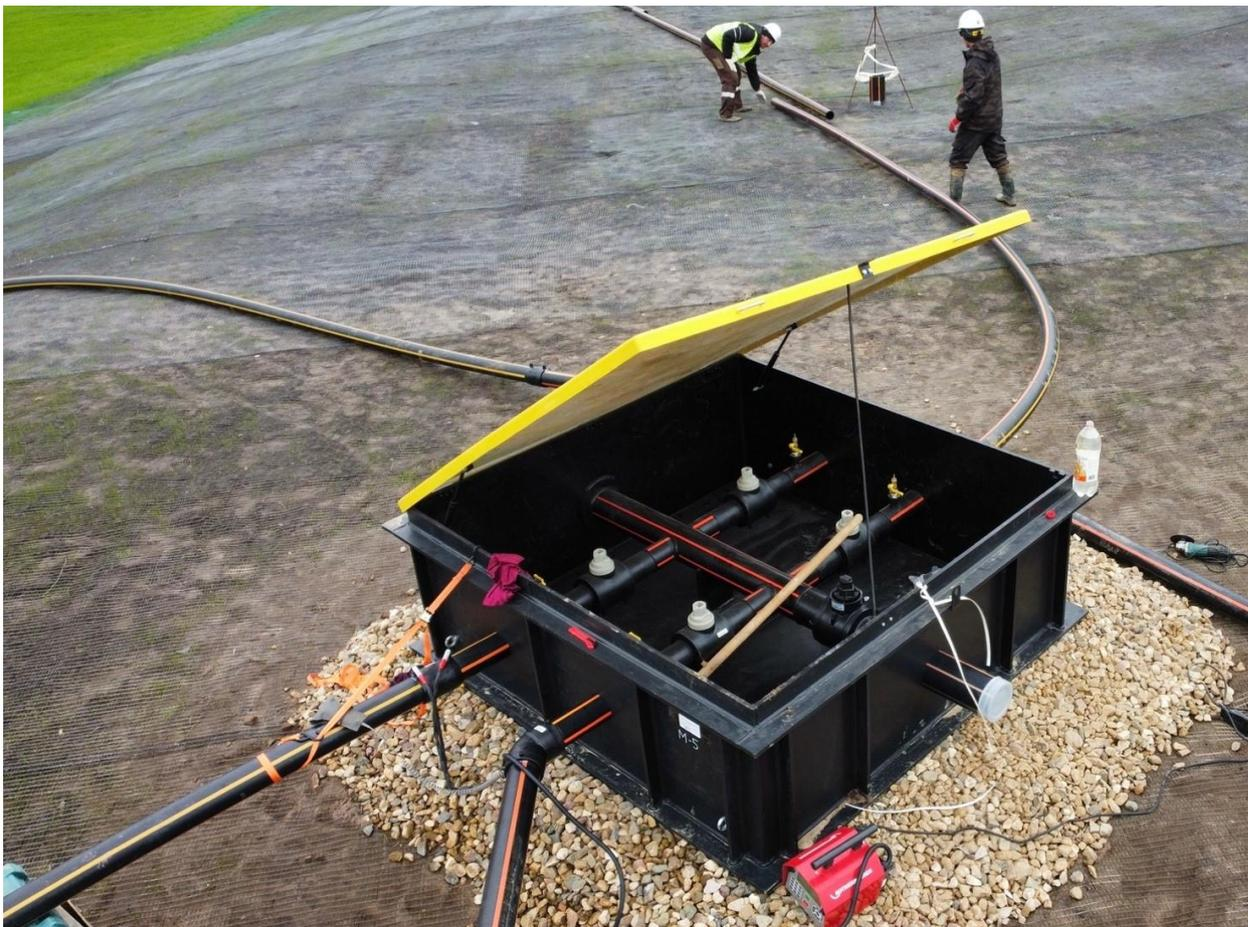
Рисунок 14 – Монтаж коллектора
