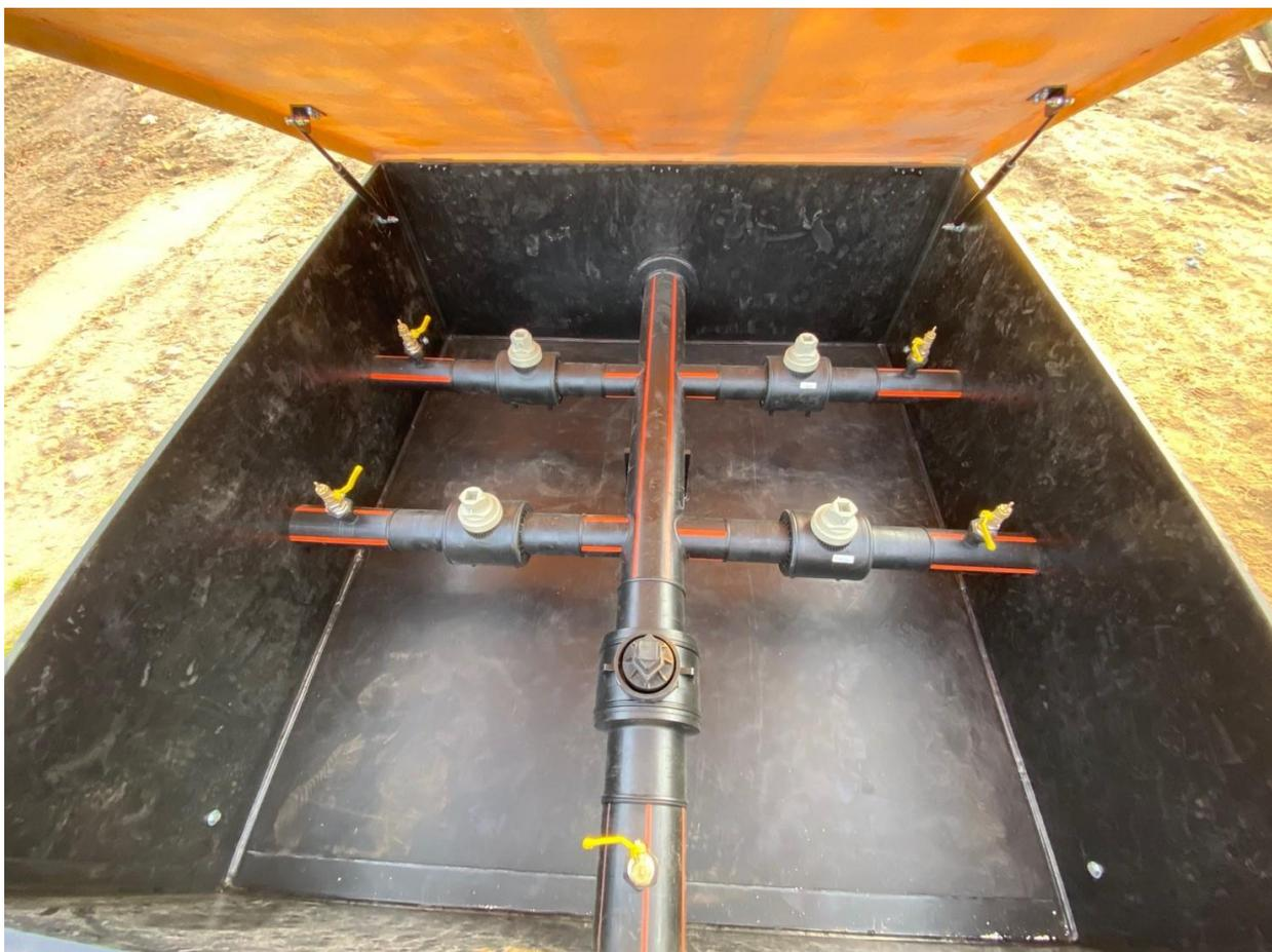
Рисунок 15 – Система вентилей в коллекторе
