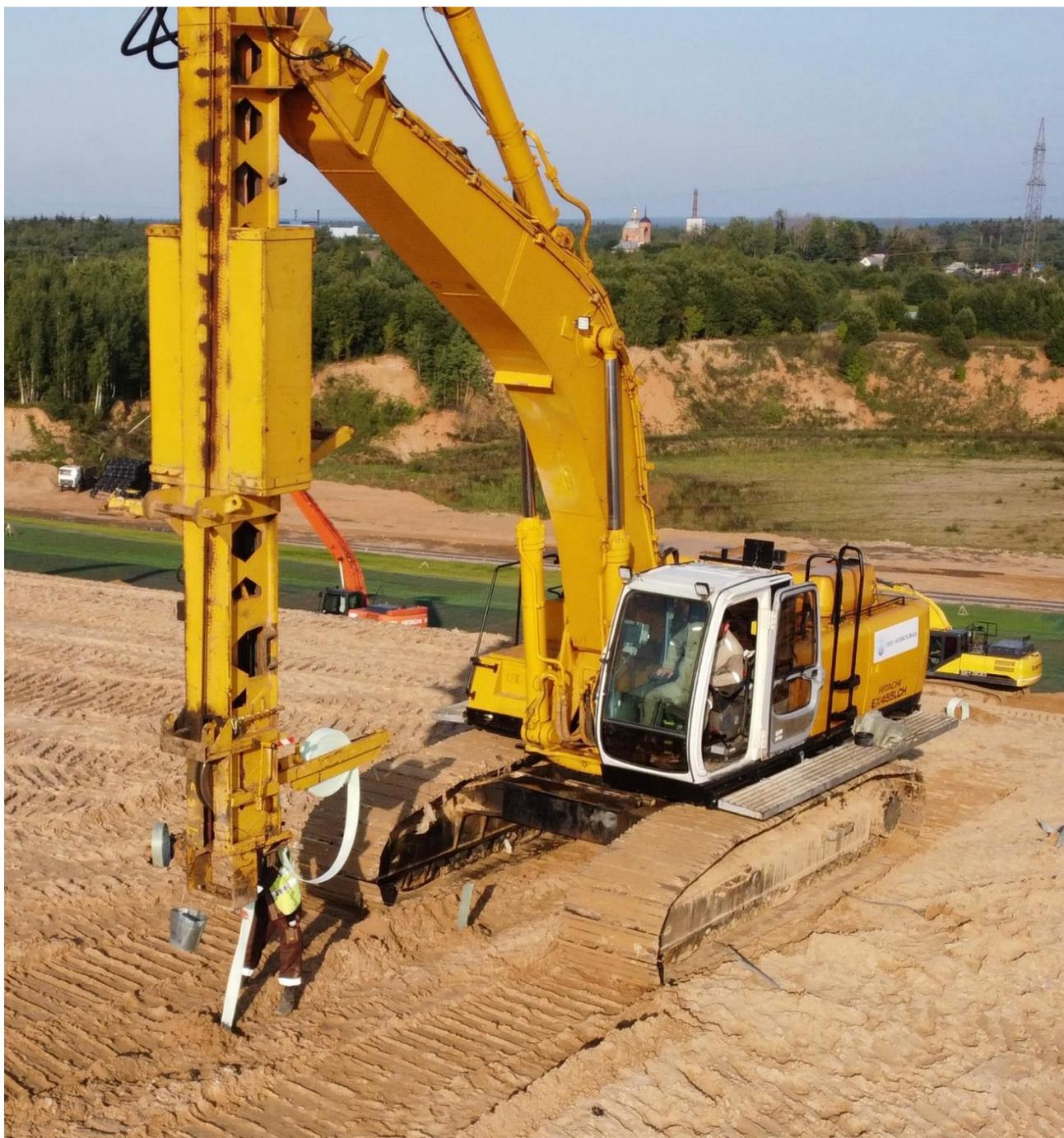
*Рисунок 5 – Общий вид гидравлического погрузателя - машины для монтажа вертикальных ленточных дрен*
