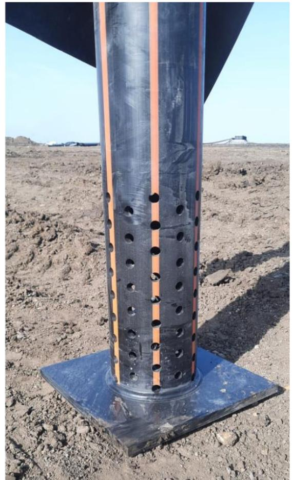
Рисунок 12 – Общий вид газосборного колодца
