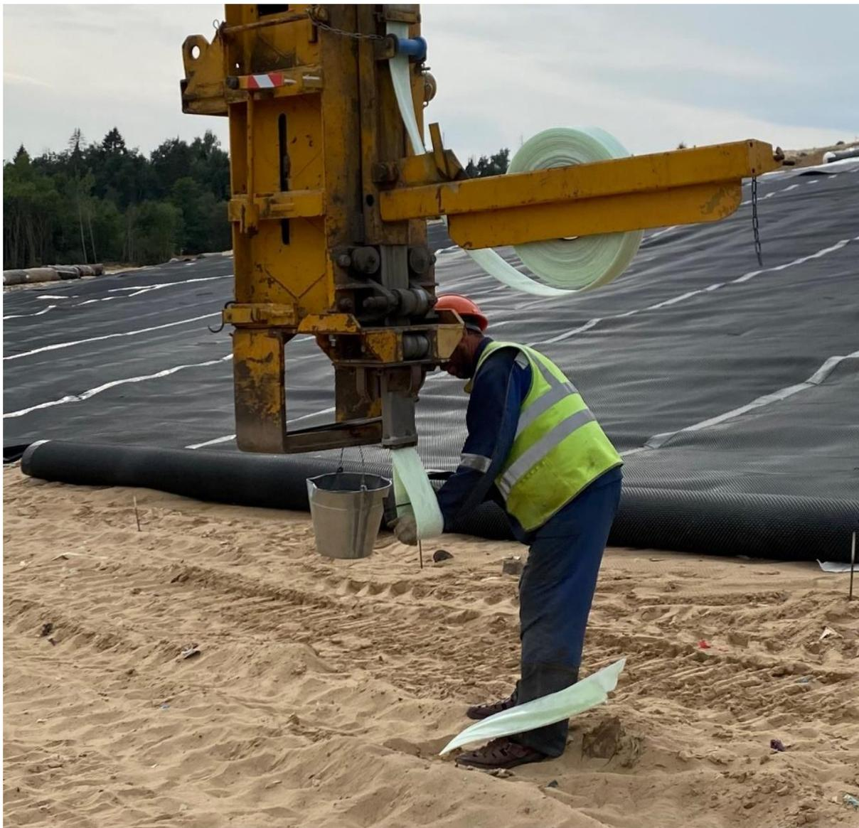
*Рисунок 7 – Отрезание вертикальной ленточной дрены*
