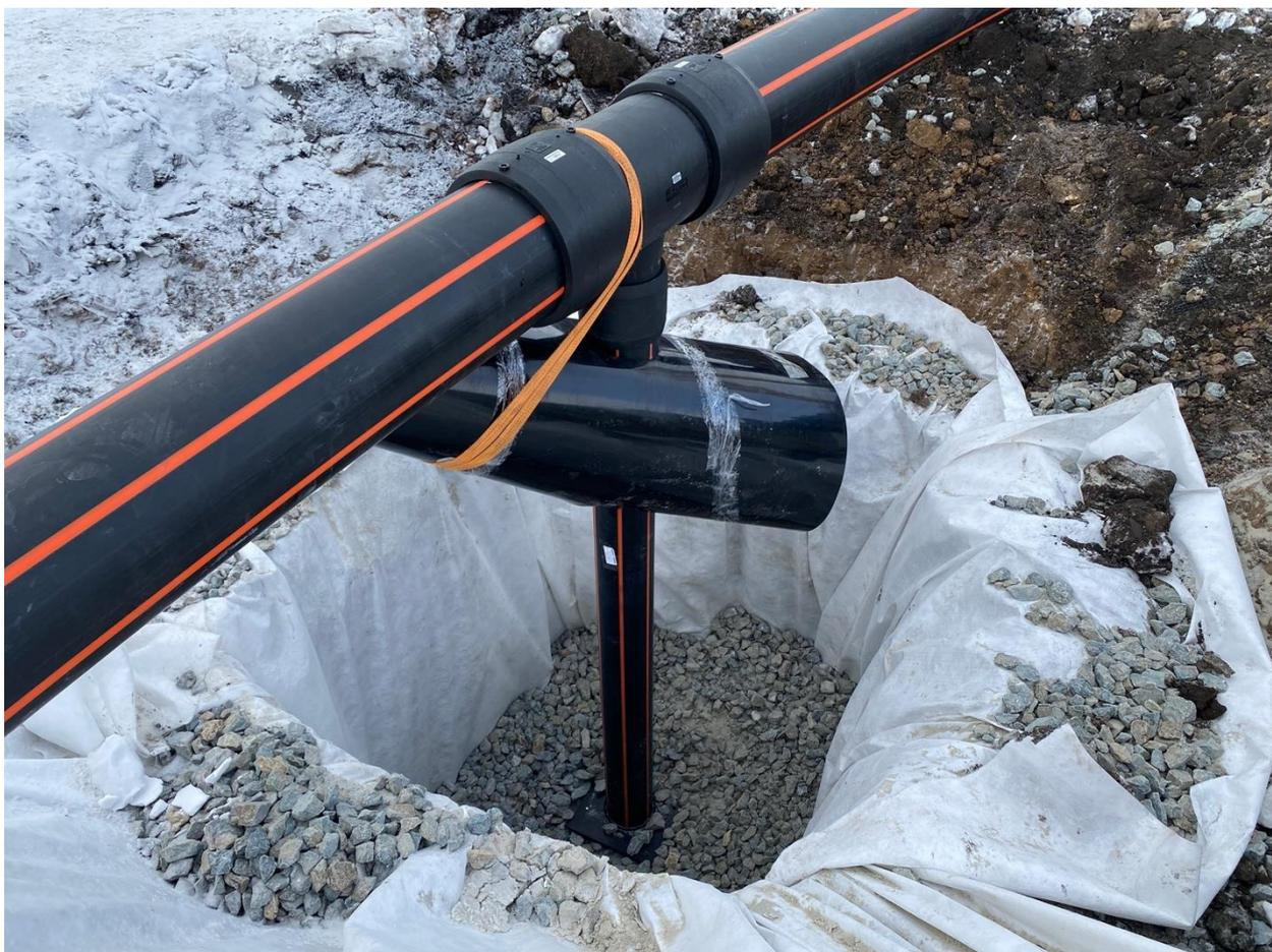
*Рисунок 16 – Конденсато-отводящий сифон*
