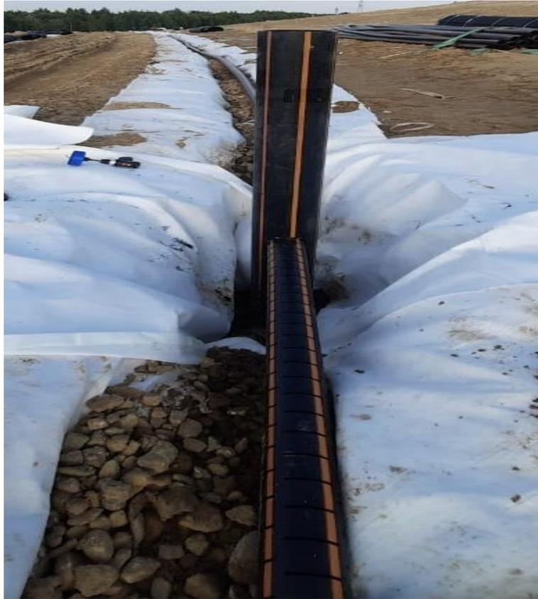
Рисунок 11 – Смонтированная дренажная система с газоконденсатосборными колодцами
