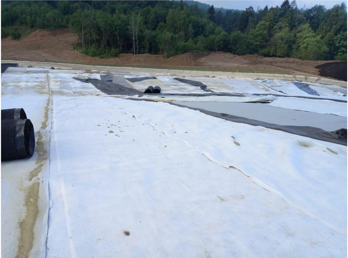
*Рисунок 2 – Укладка геотекстиля на поверхность полигона*
